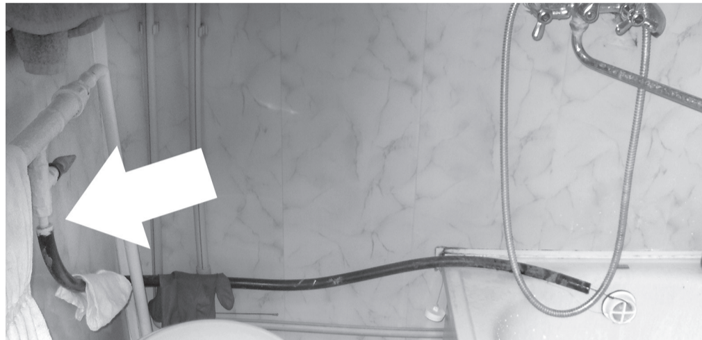
Типичная картина: из батареи отопления вода подается сразу в ванну
